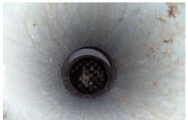
Figuur 26 Inspectie infiltratiekratten (Floris Boogaard en Jeroen Rombout, 2008)
