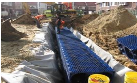
Figuur 7 Infiltratiekratten (Tilburg, 2006-11-20 Q-bic krat aanleg)
