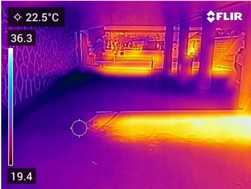
Bijlage 20 Viaduct HSL hitte-camera
