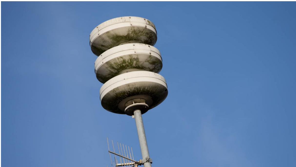
Figuur 10: WAS-systeem – Geluidsmast (NOS, 2019)
