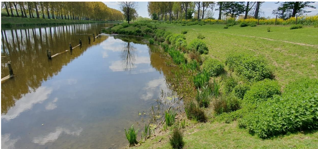
Figuur 9: Voorbeeld NVO met vooroeververdediging in Schuring, Hoeksche Waard.
